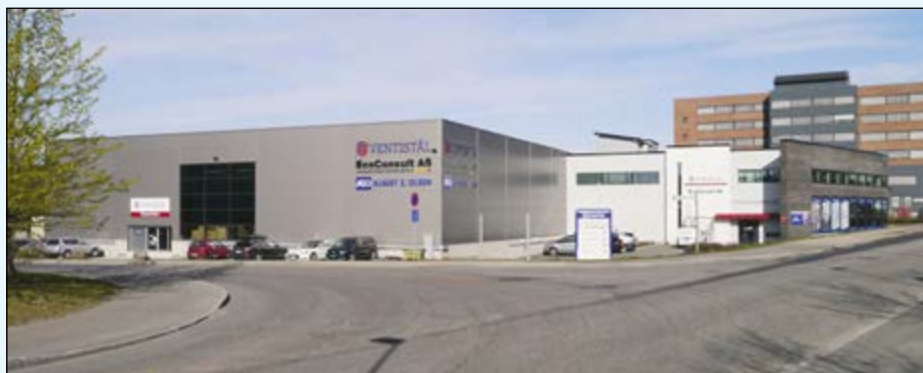
Hovedkontorene til VENTISTÅL og EcoConsult har flyttet sammen i nye lokaler på Alnabru i Oslo med 1000 m 2 kontorer og felles sentrallager på 10.000 m 2 .
