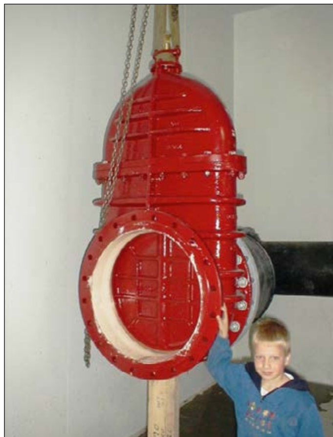
Stengeventil for sjøvann til energisentralen.
