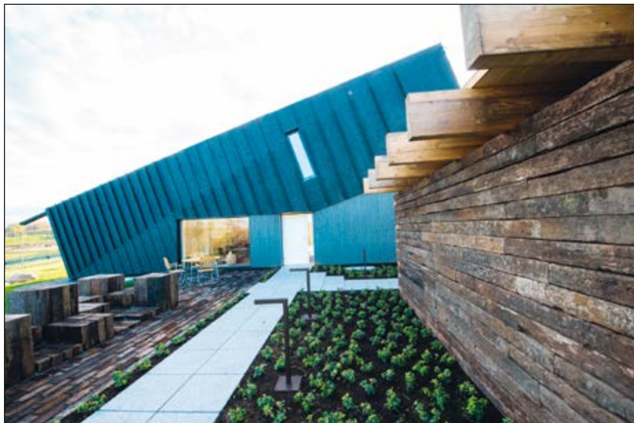
Ved siden av å generere nok energi til eget forbruk kan Multikomforthuset, Nord-Europas råeste plusshus distribuere energi videre til strømmettet, lade elbilen eller varme et svømmebasseng.
