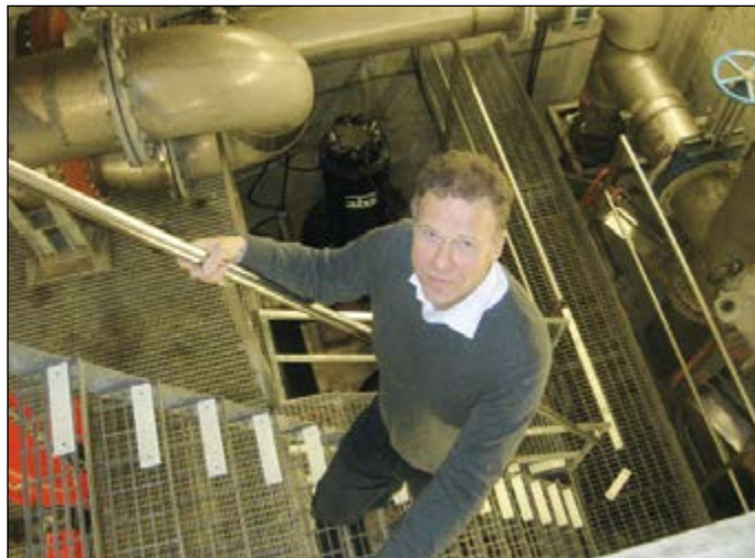
Atle Nørstebø i fjernvarme- og fjernkjøleanlegget i fjellet i Sandvika. Varmen hentes v.h.a. varmepumper fra kloakkledningen som går med selvføll fra Oslo til Slemmestad.
