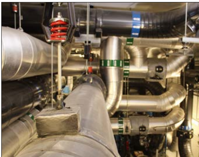
Fjæroppheng av store rør. Foto: Trygve Mellvang-Berg/Norsk Fjernvarme
