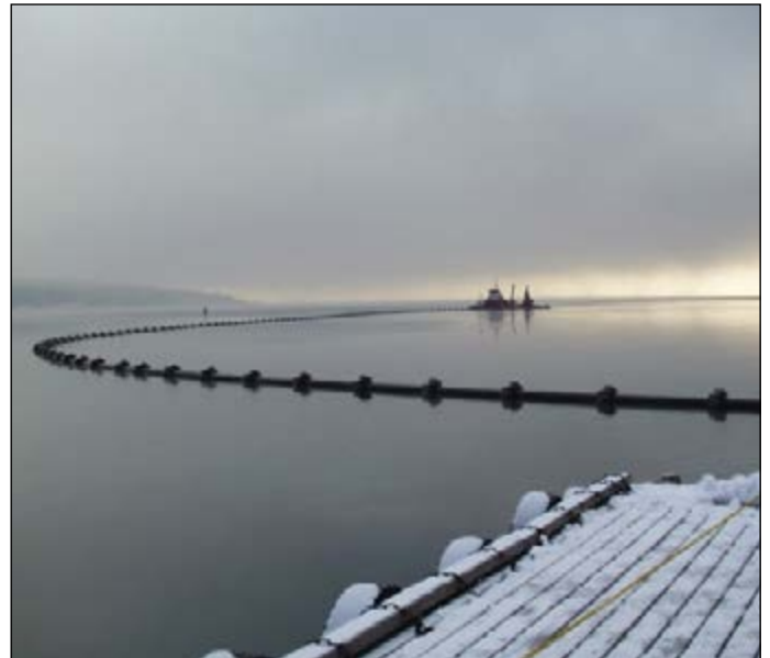
Klargjøring av sjøvannsledning før senking til sjøbunnen
