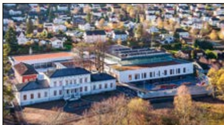
Frydehaug skole er Norges første «nær-nullenergi» skole.
