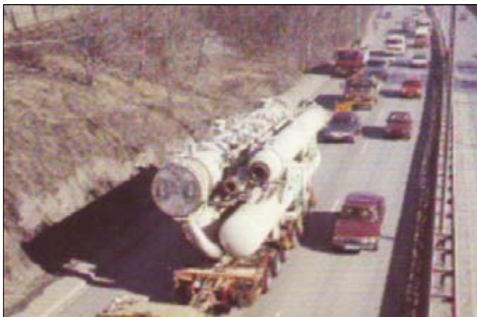
Den ene varmepumpen under transport på E-18 i 1987.
