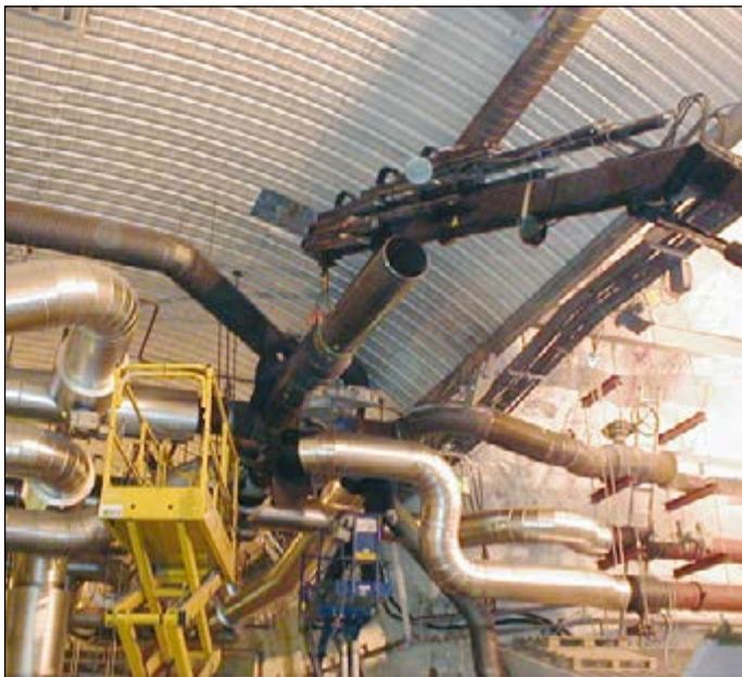
Rørarbeid i høyden. Forberedelse for tilknytning av varmepumpe nr. 3.
