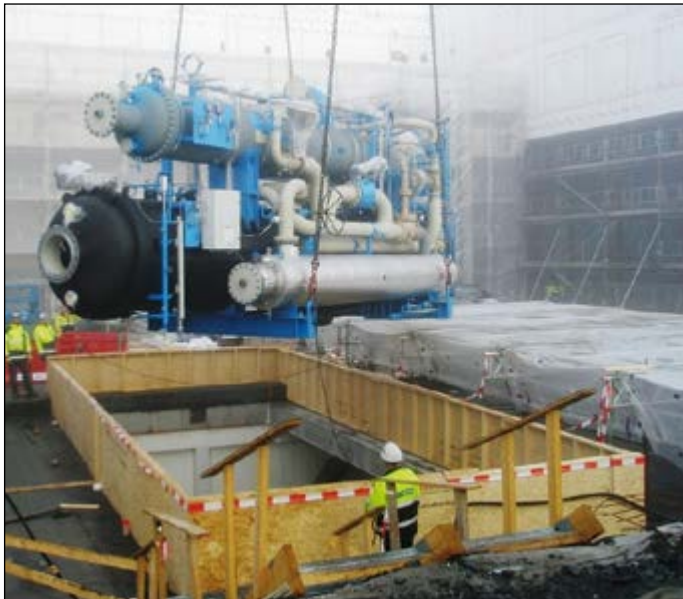
Innheising av den ene varmepumpen på ca. 30 tonn.
